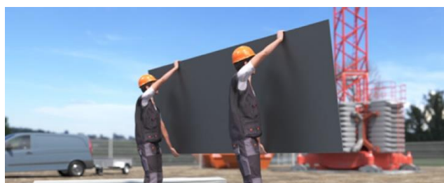
Figura 6.2: Transporte en obra.
